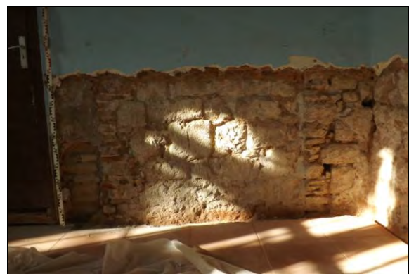
Vista de les reparacions amb maons per omplir l'espai d'una porta anterior de majors dimensions
