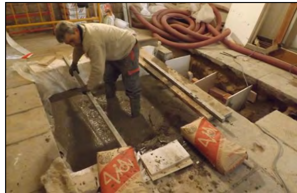
Protecció dels elements amb geotèxtil i tasques d'instal·lació de l'ascensor
