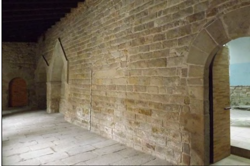
Vista del mur exterior de la Sala on es veu l'accés per la porta des del passadís del claustre
