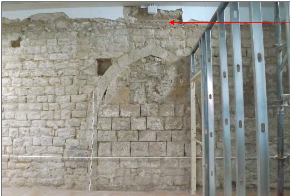
Vista de les restes d'arrencament de la volta de maons (marcat amb la fletxa vermella)
