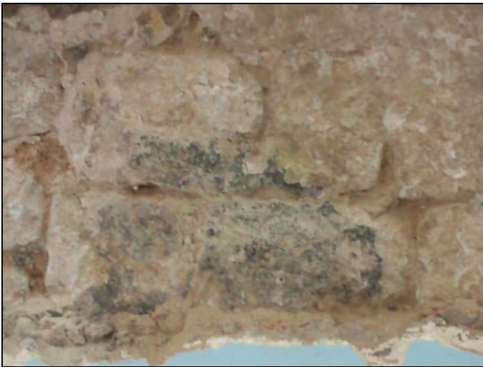
El recobriment amb mangra sobre els carreus
