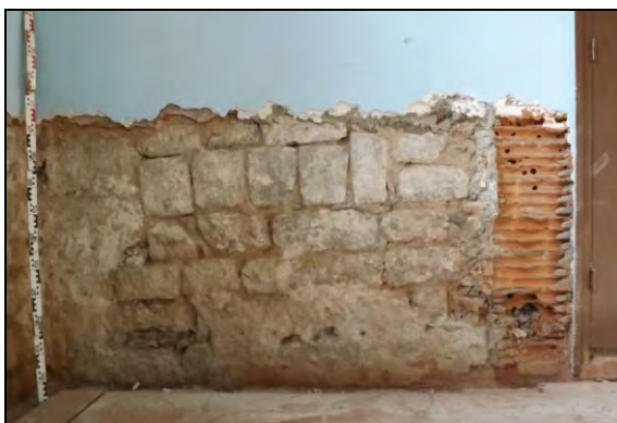
Vista de les reparacions amb maons per omplir l'espai d'una porta anterior de majors dimensions
