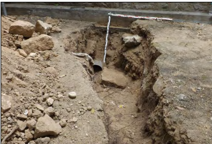
Vista de l'inici de la Rasa 1 amb el tub de la canalització que es va fer l'any 2007
