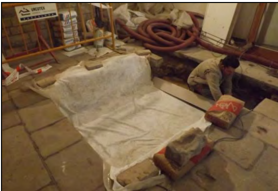
Protecció dels elements amb geotèxtil i tasques d'instal·lació de l'ascensor
